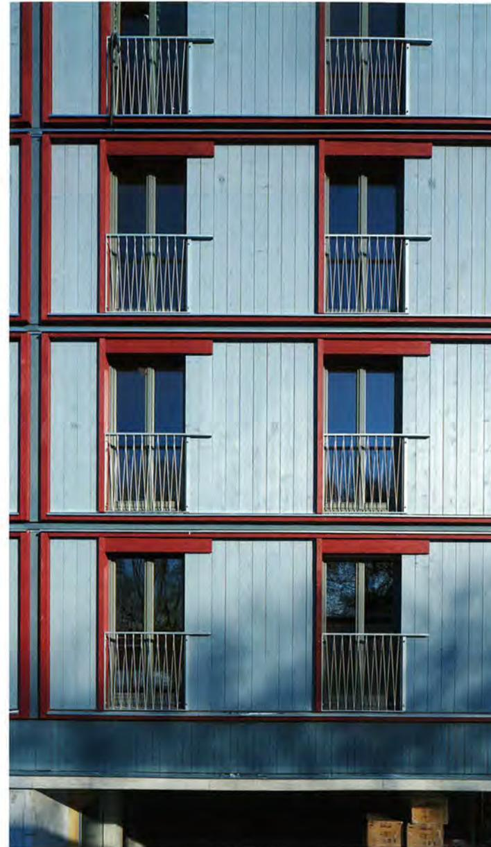
Der rote Rahmen und seine taubenblaue Füllung aus sägeraem Holz zeigt nicht nur die Bauweise; die Proportion der Fassade strahlt eine gewisse Strenge und Ruhe aus. Unten: Die Nasszellen wurden im Stück eingesetzt
